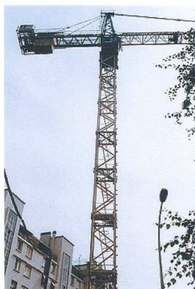
Echelles inclinées avec paliers intermédiaires.
